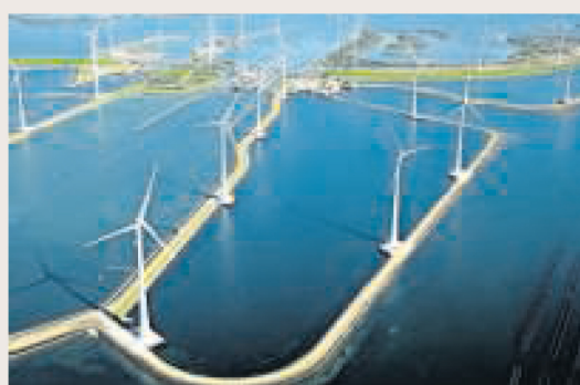
▲ Windpark Krammer. FOTO WINDPARK KRAMMER
