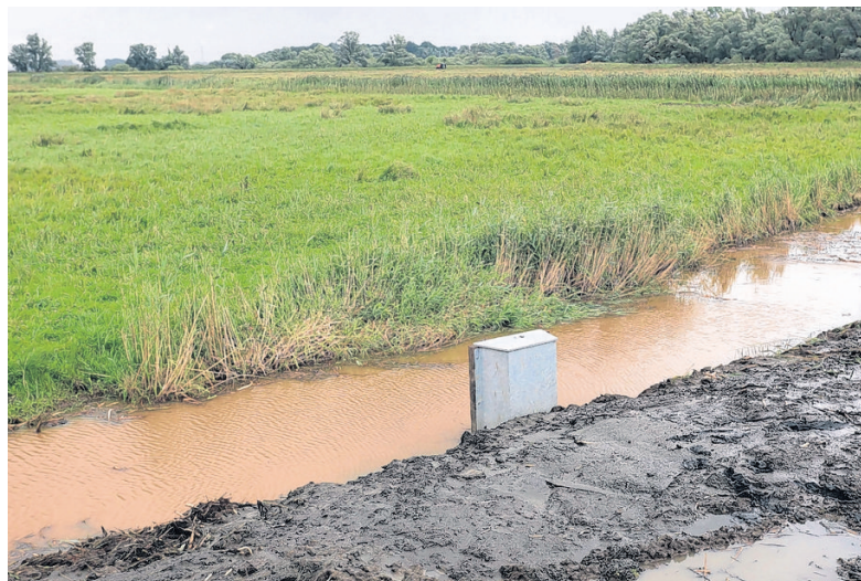
▲ Aan de binnenzijde van de polder is een niveau-regelaar geplaatst. Met schotbalkjes kan de waterstand worden verhoogd.
